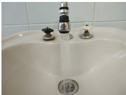
Рисунок 5 – течение жидкости через насадку-аэратор.
