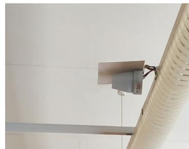
Рис 7. Установка фотореле
