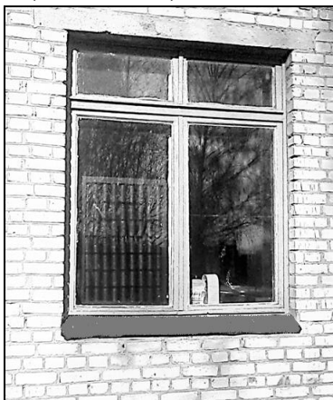
Фото 2. Использование дачного коллектора в школе
