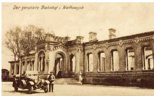
Разрушенный железнодорожный вокзал Волковыск-город (фото 1915 года)
